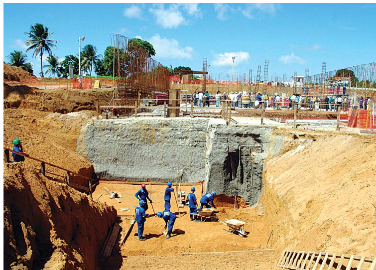
Obra do Reservatório Apoiado, que terá vazão para 10 mil metros cúbicos d'água
